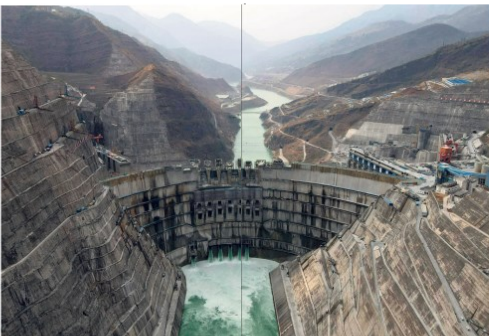
Lo sbarramento di Balhetan, nello Yunnan (foto del 2021)
